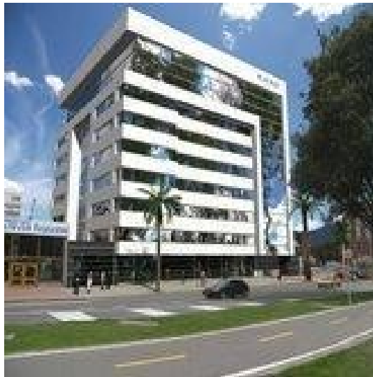
Torre platino Edificación de 9 pisos y 3 sótanos (13.000 m2)
